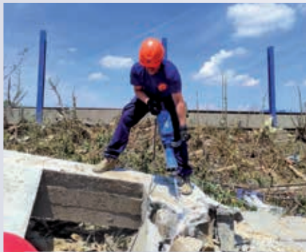
Dobrovoľník civilnej ochrany za pomoci zbíjacieho kladiva likviduje pozostatky protihlukovej steny, ktorú poškodilo tornádo
